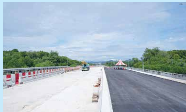
RUPA bentuk Jambatan Batu Kawan yang bakal melicinkan trafik sedia ada.
